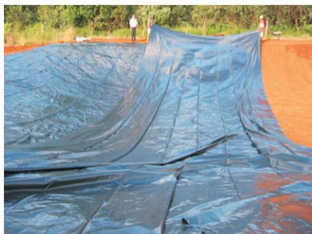
Figura 8. Colocação da lona de revestimento.
