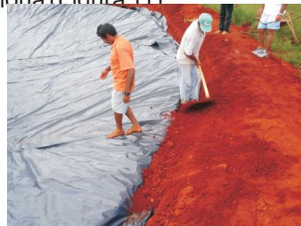
Figura 11. Aterramento da valeta para fixação da lona.
