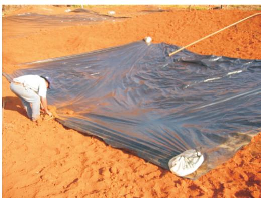
Figura 17. Colocação de lona no centro do reservatório, antes da entrada da água.
