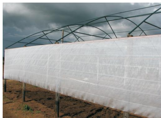
Figura 10. Colocação do clarite para fechamento das laterais.
