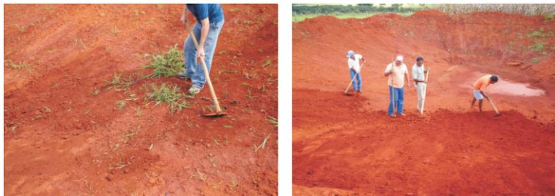
Figura 5. Operação de limpeza e regularização do terreno.
