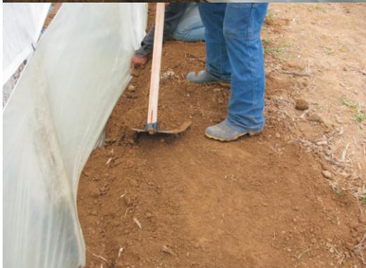
Figura 13. Colocação e aterramento do filme plástico que faz o fechamento da parte inferior da estufa.
