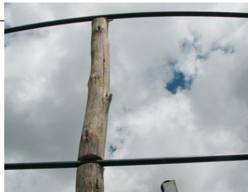
Figura 8. Detalhe da fixação do arco na estaca frontal da estufa.
