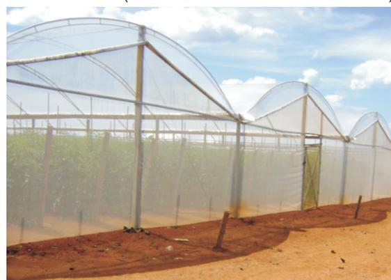
A madeira de eucalipto é utilizada para sustentação da estrutura e pode receber ou não tratamento prévio. Quando se faz o tratamento da madeira, a durabilidade é ampliada, e pode durar até 20 anos. Os arcos, que podem ser construídos com tubos de ferro chapa
