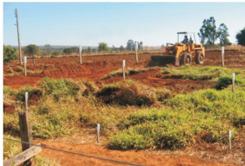
Figura 3. Ilustração da demarcação do terreno.
