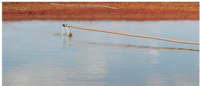
Figura 21. Uso de boia para manutenção do nível do reservatório.
