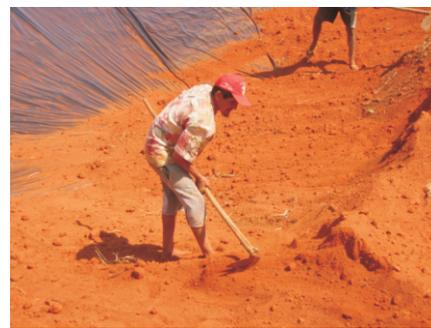
Figura 14. Nivelamento da terra sobre a lona.
