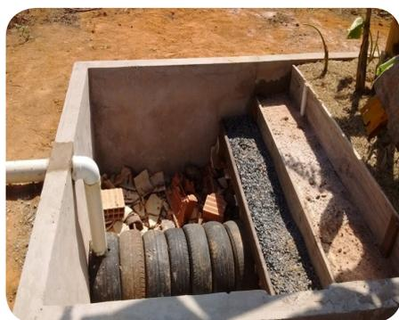
Figura 3. Câmara de fermentação anaeróbica
