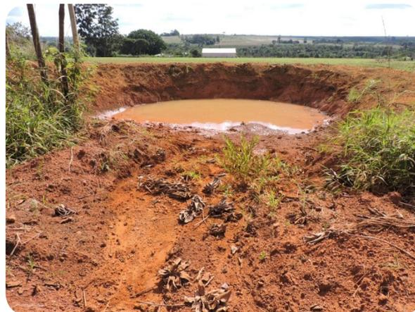
Figura 4. Bacia de contenção de água da chuva
