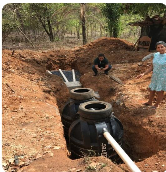
Figura 2. Filtro anaeróbico
