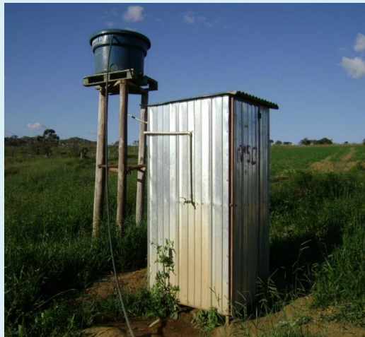
Figura 3: Modelo de banheiro próximo ao local de trabalho.
