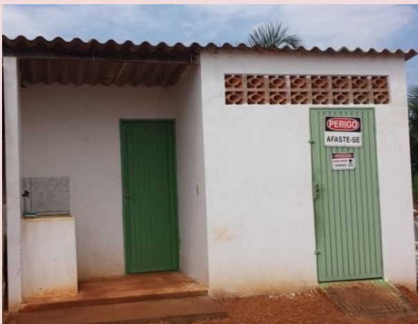
Figura 20: Depósito de agrotóxico.
