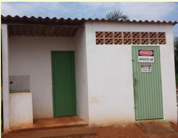
Figura 20: Depósito de agrotóxico.
