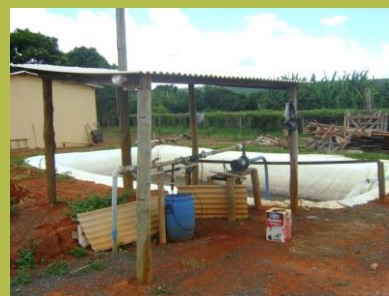
Figura 27: Cobertura para cabeçal de controle da irrigação
