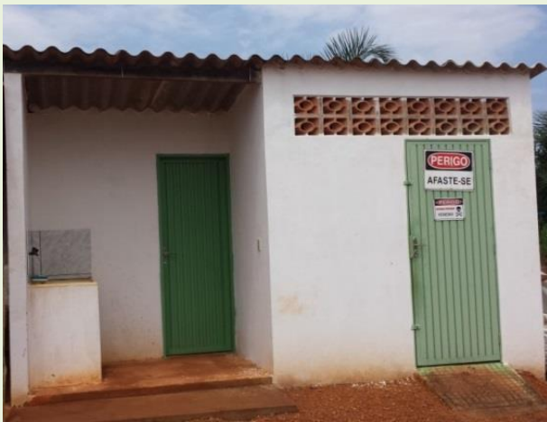
Figura 20: Depósito de agrotóxico.
