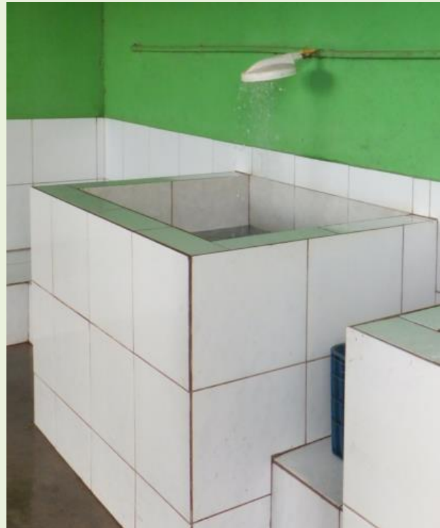
Figura 31: Tanque de aspersão.
