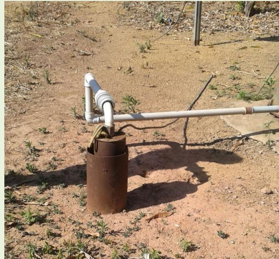
Figura 29: Poço tubular profundo.
