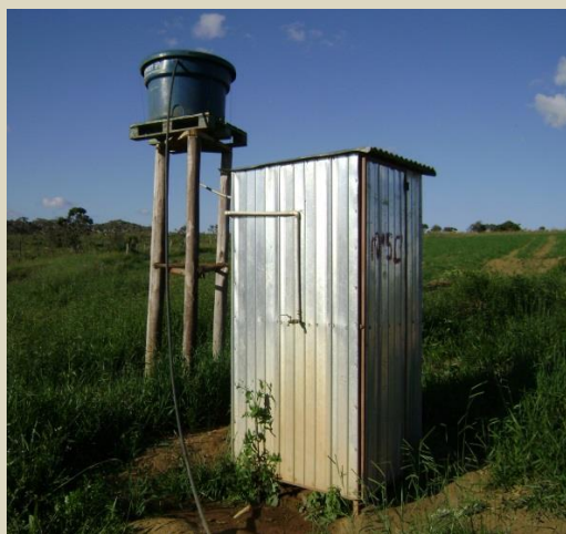
Figura 3: Modelo de banheiro próximo ao local de trabalho.
