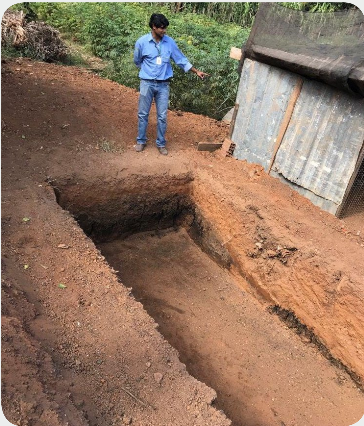
Figura 2. Escavação do tanque. Fonte: Emater-DF
