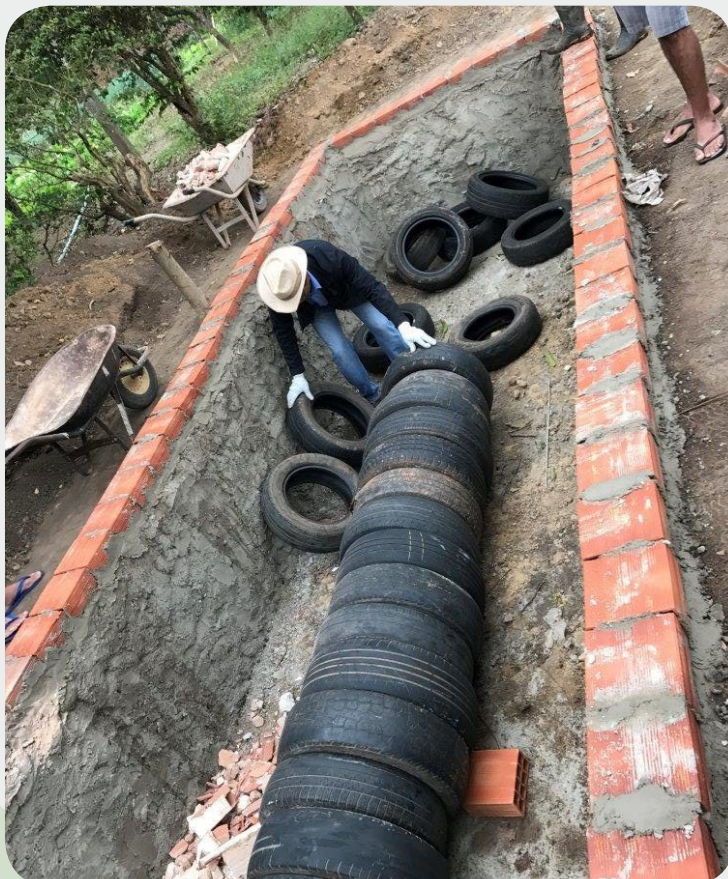
Figura 3. Colocação dos pneus. Fonte: Emater-DF
