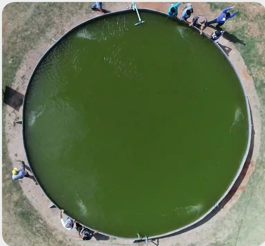
Figura 2. Vista área do tanque circular de ferrocimento no AgroBrasília, com detalhe do sistema de aeração com bicos injetores.
