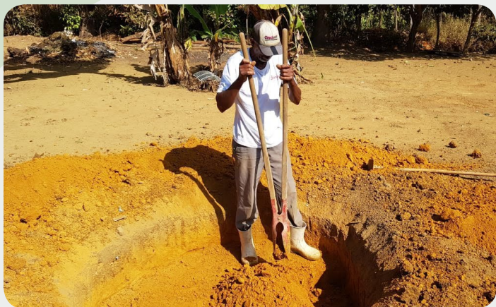
Figura 7. Escavação da vala circular. Fonte: Emater-DF
