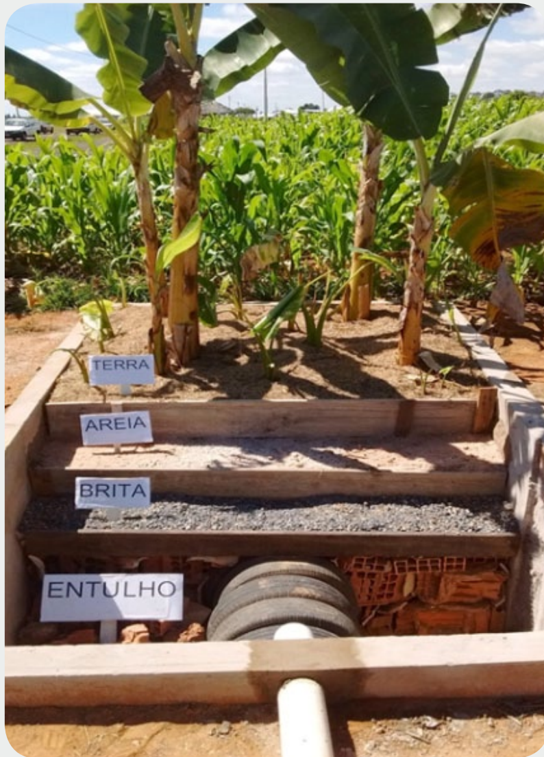
Figura 1. Exemplo de tanque de Evapotranspiração. Fonte: Emater-DF
