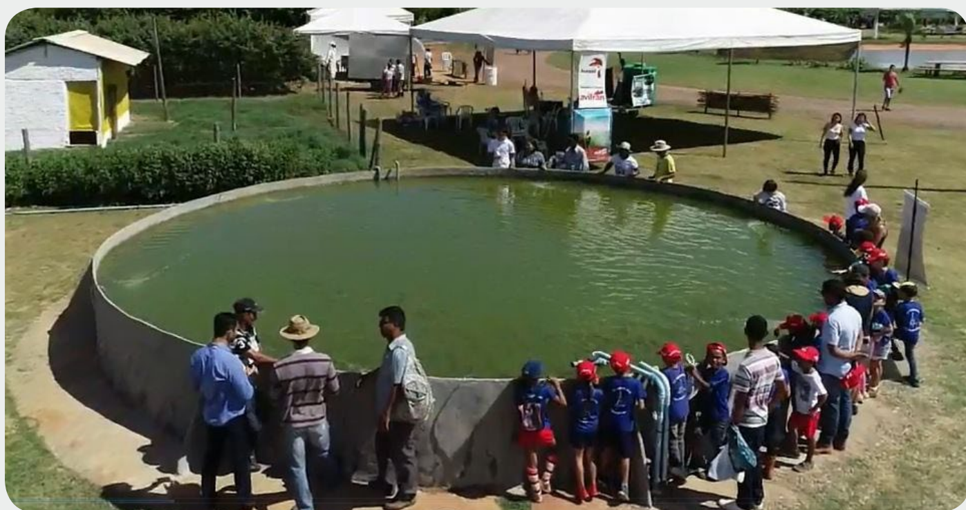
Figura 1. Vista lateral do tanque circular de ferrocimento no AgroBrasília, com detalhe do sistema de aeração com bicos injetores.
