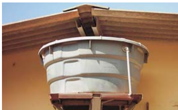
Figura 13. Caixa de água fora do galpão.
