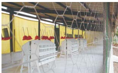
Figura 44. Galpão em vazio sanitário.
