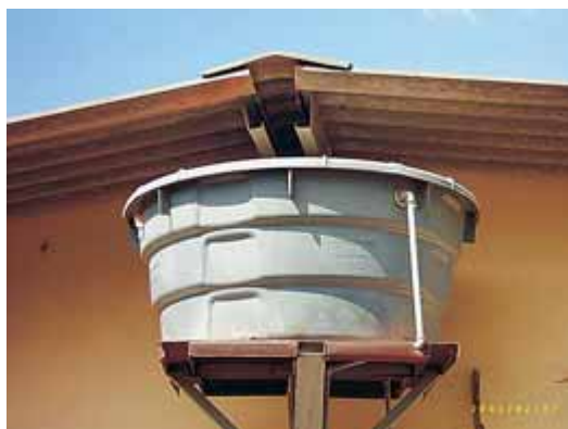
Figura 10. Caixa de água fora do galpão.
