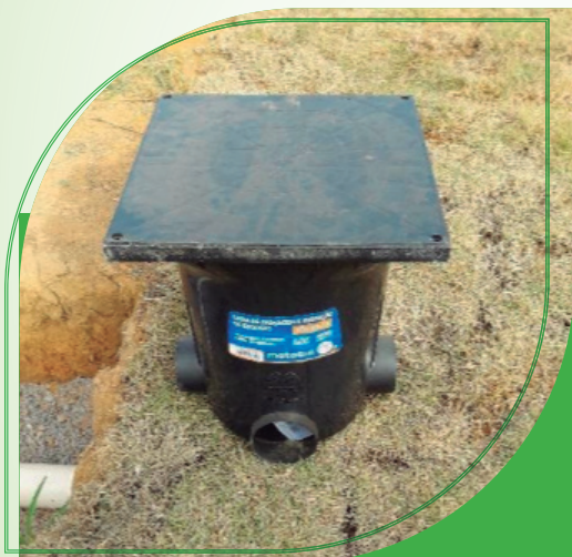
Figura 01. Caixa de gordura. Fonte: Emater-DF.
