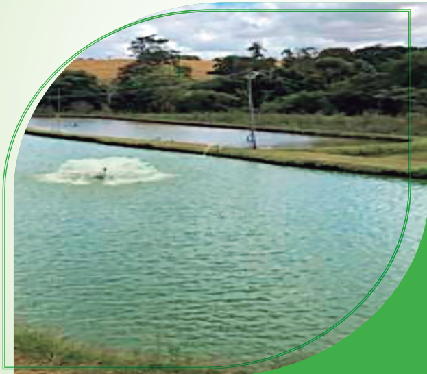
Figura 03. Vista geral dos viveiros escavados e aeradores utilizados na Fase 02.
