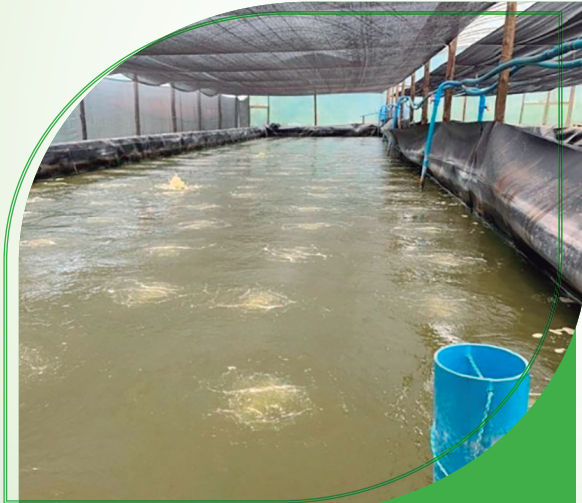
Figura 02. Tanque pré-moldado com aplicação de geomembrana em PEAD. Fonte: o autor.
