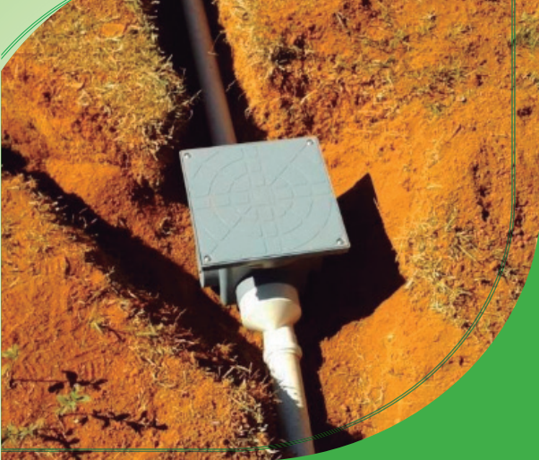
Figura 2. Caixa de inspeção ou de passagem. Fonte: Emater-DF.
