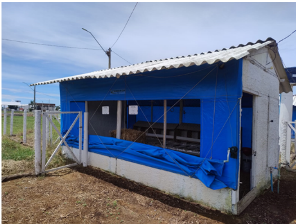
Figura 02. Galpão com capacidade para 100 poedeiras. Fonte: Emater-DF
