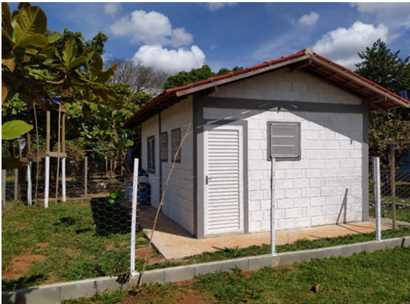
Figura 02. Cercamento de uma agroindústria. Fonte: Emater-DF
