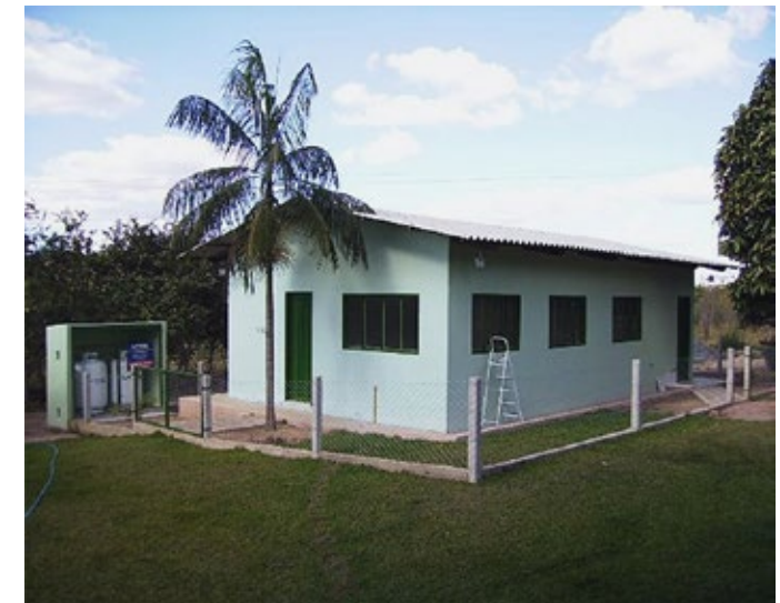
Figura 2 – Área externa da agroindústria com cercamento.
