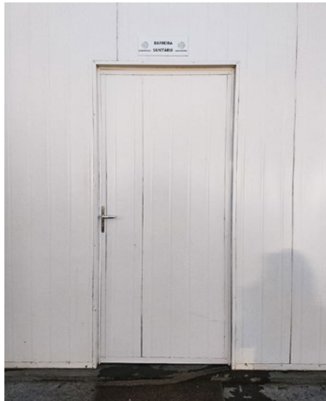
Figura 7 – Porta com revestimento de isopanel.
