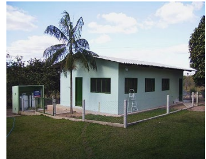
Figura 2 – Área externa da agroindústria com cercamento.
