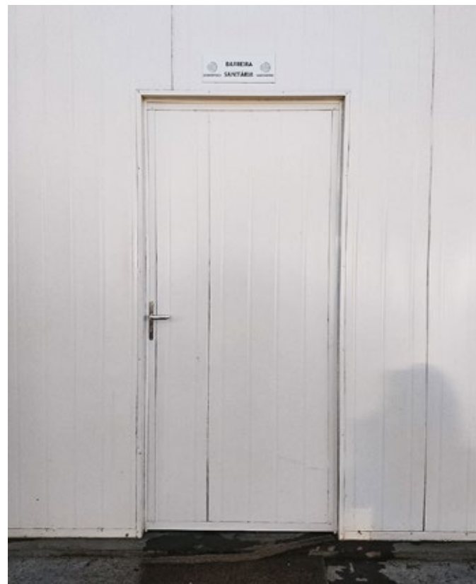
Figura 7 – Porta com revestimento de isopanel.
