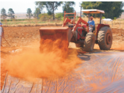
Figura 12. Colocação da terra com auxílio do trator.
