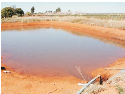
Figura 1. Exemplo de reservatório escavado no solo sem revestimento e sua representação esquemática.
