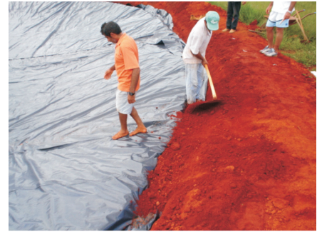
Figura 11. Aterramento da valeta para fixação da lona.
