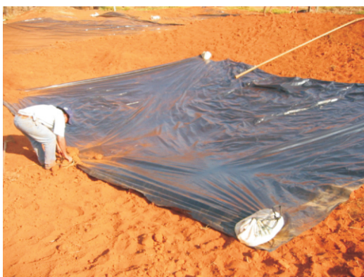
Figura 17. Colocação de lona no centro do reservatório, antes da entrada da água.
