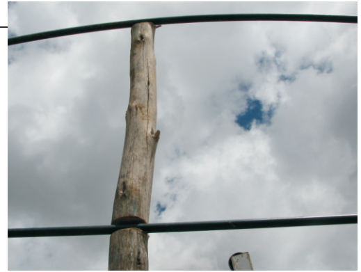
Figura 8. Detalhe da fixação do arco na estaca frontal da estufa.
