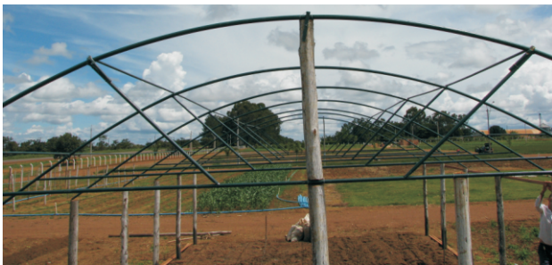
Figura 9. Vista da cobertura após a colocação dos tirantes.
