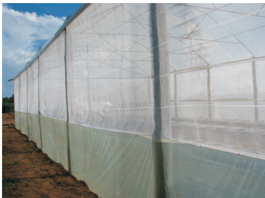
Figura 14. Aspecto do fechamento da lateral da estufa.
