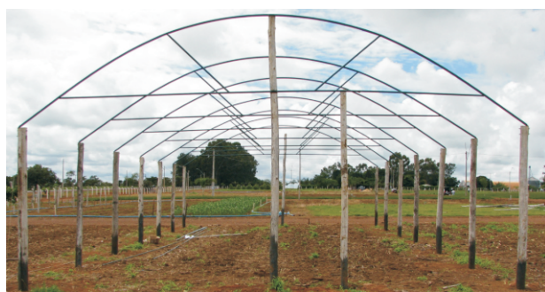
Figura 5. Vista geral da etapa inicial de construção.
