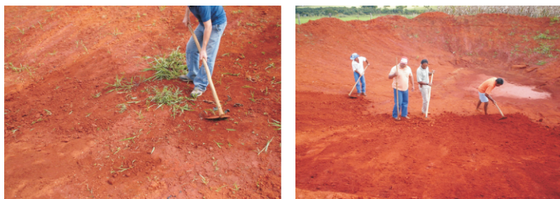
Figura 5. Operação de limpeza e regularização do terreno.
