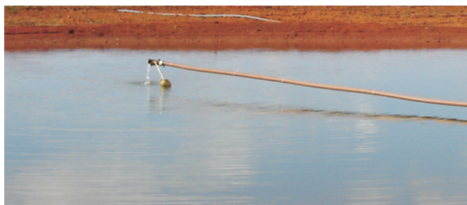
Figura 21. Uso de boia para manutenção do nível do reservatório.
