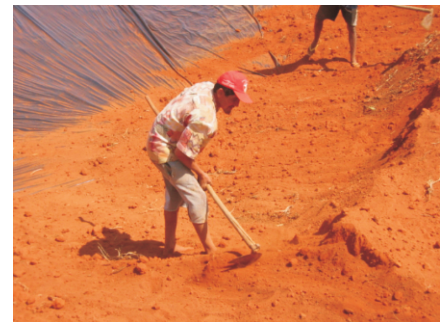
Figura 14. Nivelamento da terra sobre a lona.
