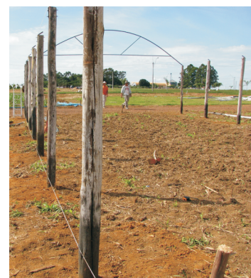
Figura 4. Alinhamento das estacas na fase inicial da construção.
