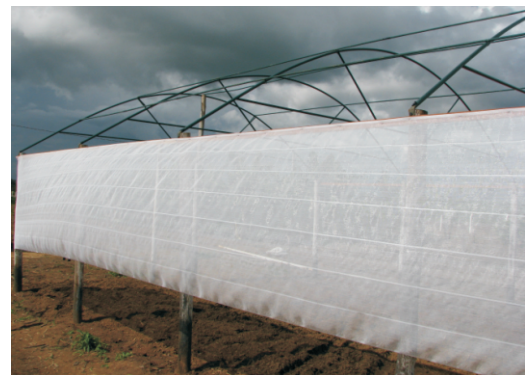
Figura 10. Colocação do clarite para fechamento das laterais.
