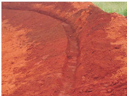
Figura 6. Valeta na borda do reservatório para fixação da lona.
