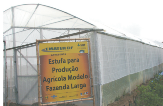
Figura 15. Fechamento da parte frontal da estufa.
