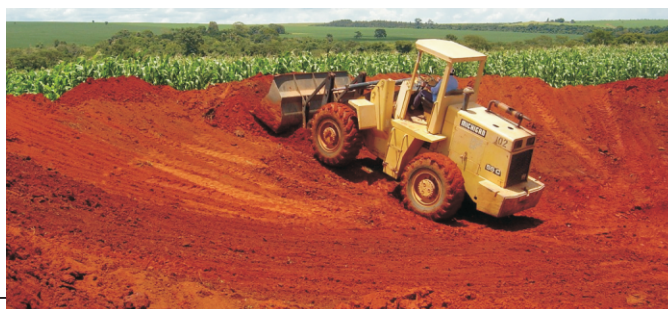
Figura 4. Fase inicial da escavação e movimentação do solo em direção à borda do reservatório.
