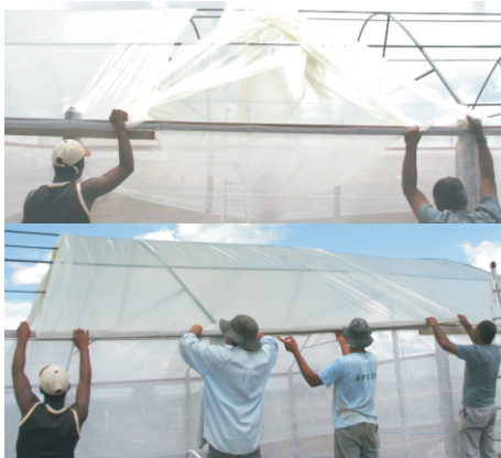
Figura 11. Colocação do filme plástico para cobertura da estufa.
