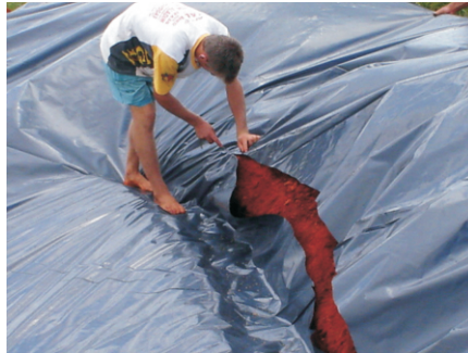
Figura 10. Corte das laterais da lona para o encaixe na valeta.
