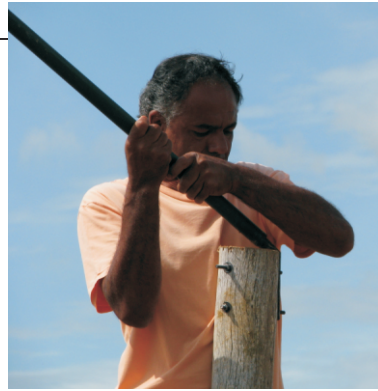
Figura 7. Fixação do arco no suporte.
