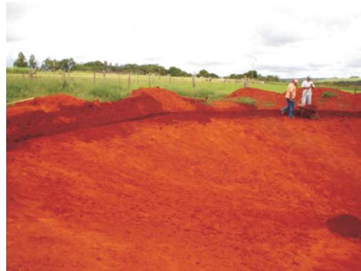
Figura 7. Vista da borda do reservatório.
