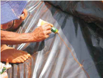
Figura 9. Uso da cola de junta de motor utilizada na emenda da lona.
