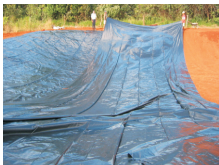
Figura 8. Colocação da lona de revestimento.
