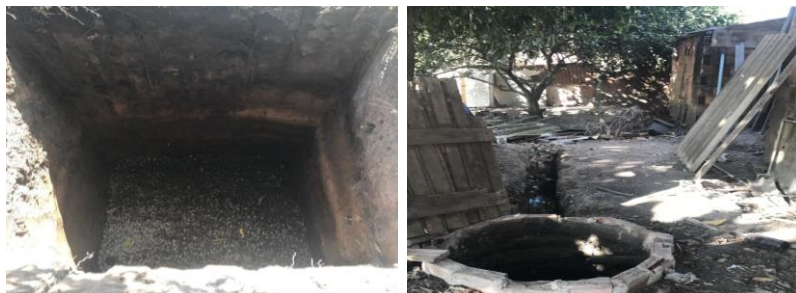
Figura 01. Modelos de fossas negras altamente poluentes.
