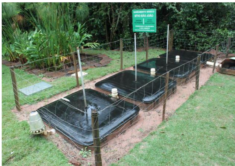
Figura 17. Fossa biodigestora modelo Embrapa.
