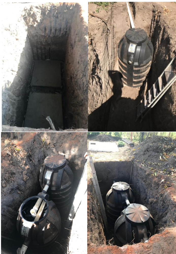
Figura 15. Sequência de montagem da fossa séptica e do biofiltro.
