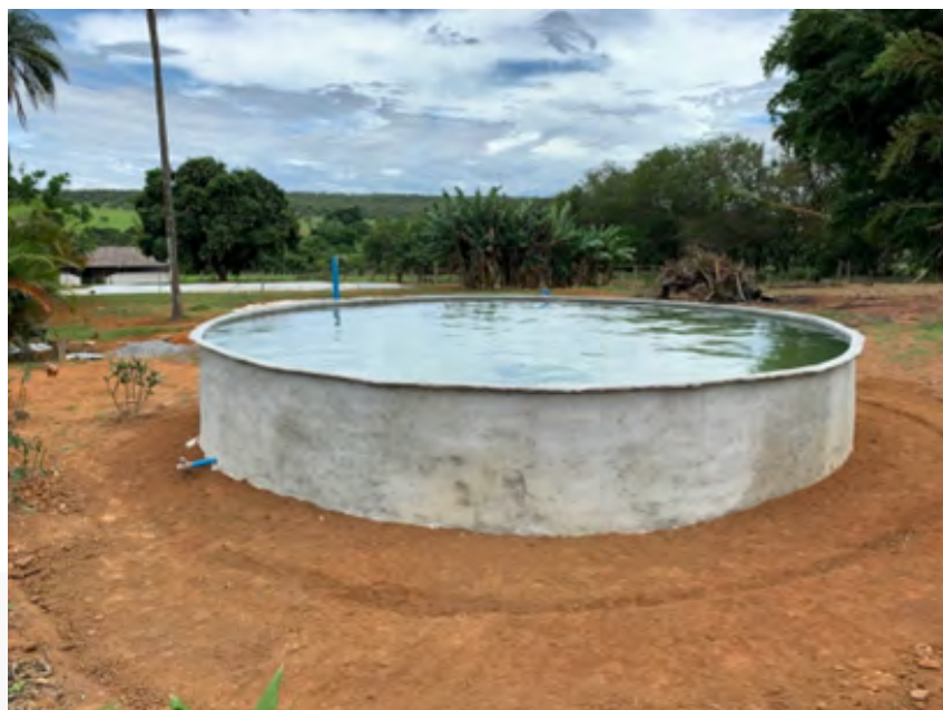
Figura 1. Tanque de ferrocimento
