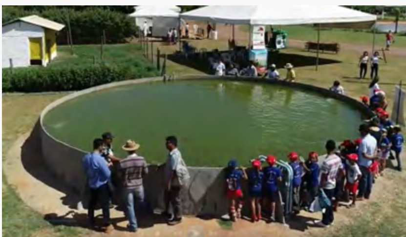
Figura 1. Vista lateral do tanque circular de ferrocimento no AgroBrasília, com detalhe do sistema de aeração com bicos injetores.
