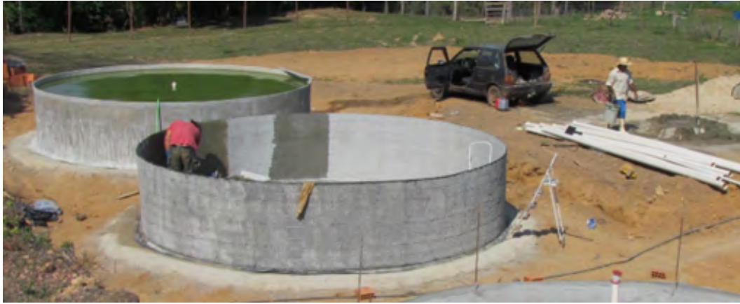
Figura 1. Construção de tanque de ferrocimento Fonte: Florence Marie Berthier
