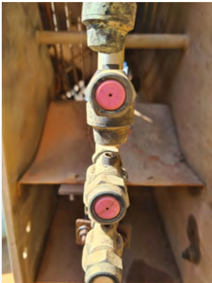
Figura 08. Detalhe dos bicos desgastados ou rachados que necessitam ser trocados.
