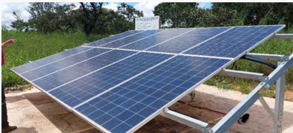
Figura 02. Placas fotovoltaicas instaladas no Assentamento Estrela da Lua. Fonte: Emater-DF.
