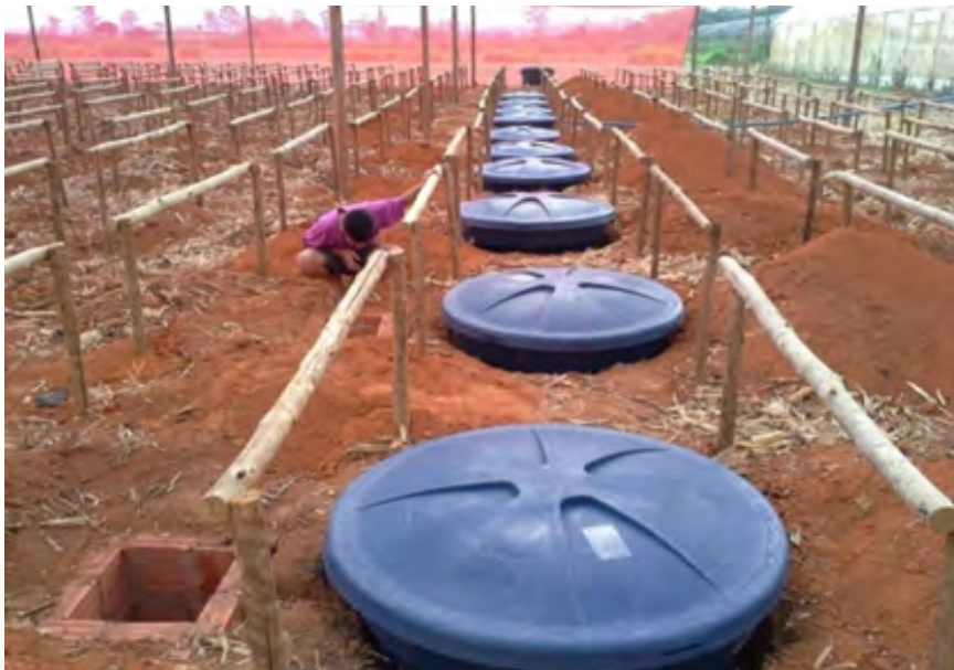
Figura 07. Reservatórios para bancadas individuais.
