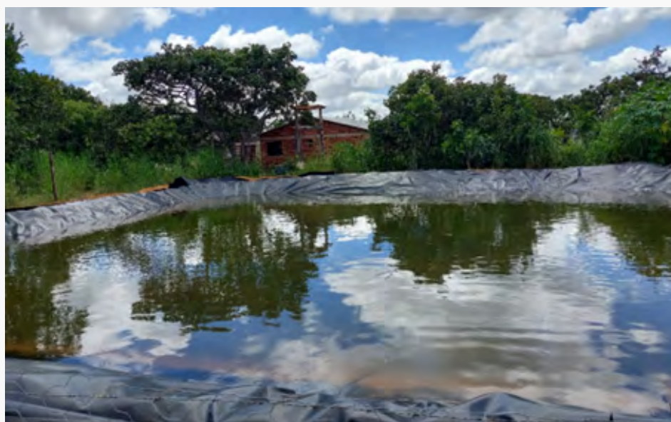
Figura 01. Tanque de armazenamento de água no Assentamento Estrela da Lua.
