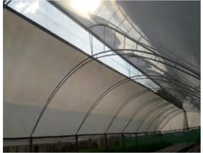
Figura 04. Estufa agrícola com abertura de Lanternim Fonte: Emater-DF
