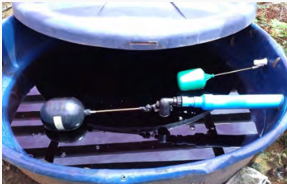
Figura 03. Controle de entrada de água.
