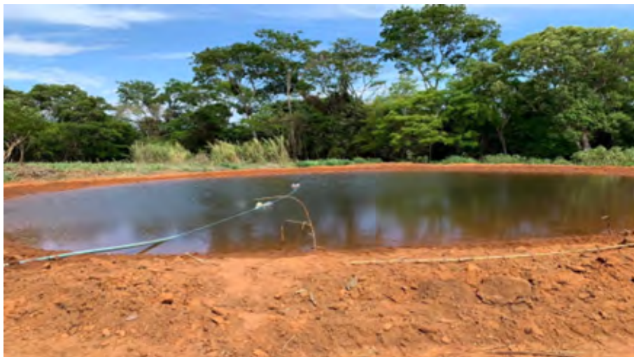
Figura 3. Reservatório escavado lonado
