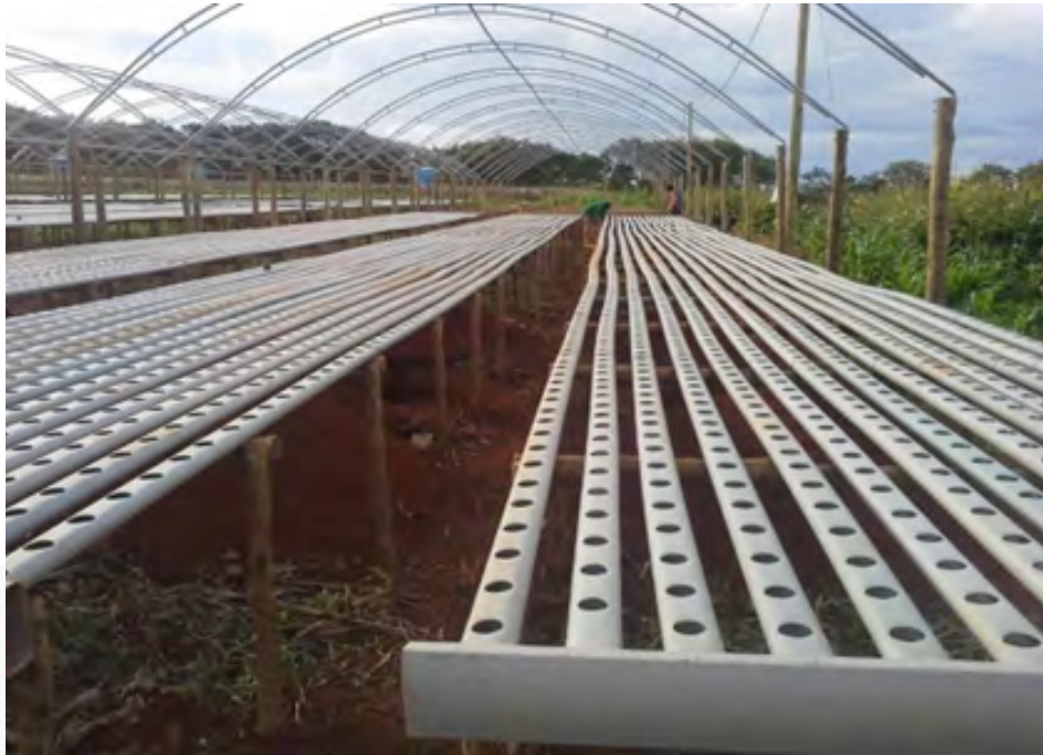
Figura 12. Montagem dos perfis na bancada.
