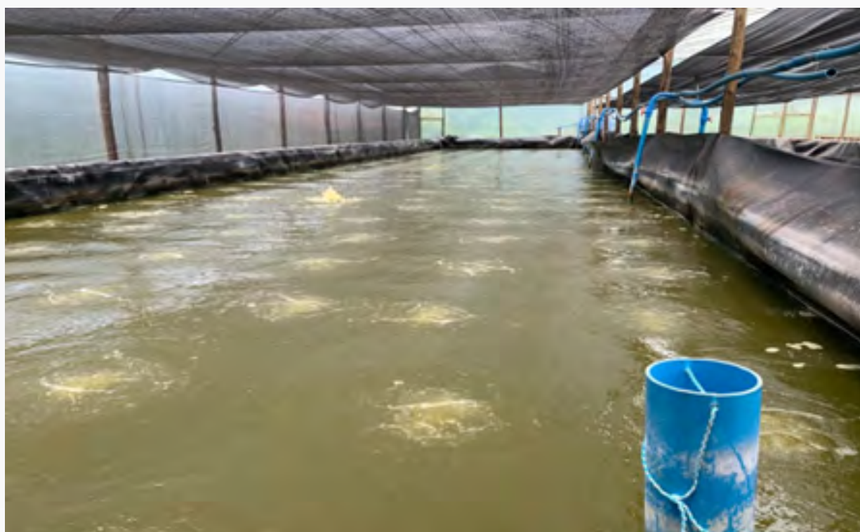
Figura 2. Tanque pré-moldado com aplicação de geomembrana em PEAD
