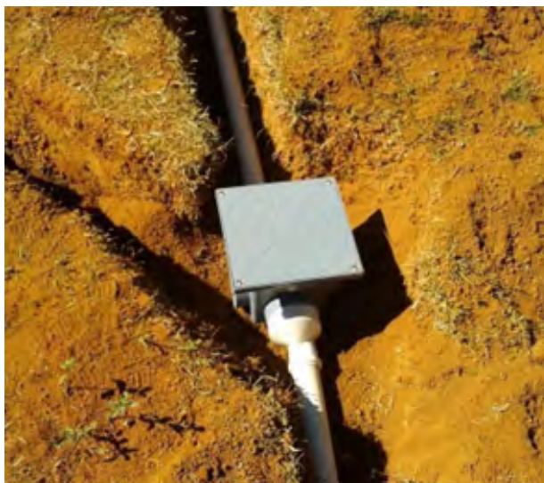
Figura 02. Caixa de inspeção ou de passagem.
