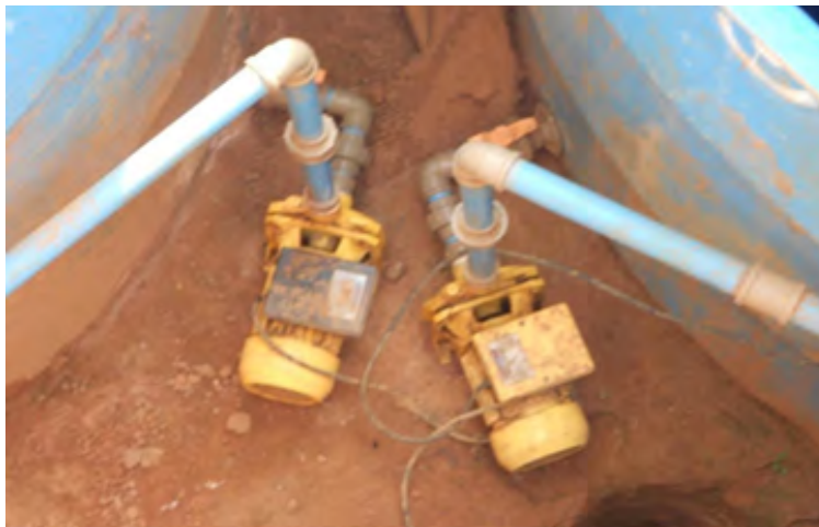
Figura 04. Motobombas afogadas para bancadas coletivas. Fonte: Emater-DF
