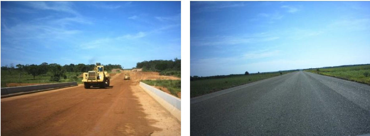
Figura 19: (a) Máquinas que trabalham no asfaltamento da TO-020; (b) Trecho asfaltado em região de cultura intensiva de grãos.
